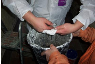
1. Préparation des bandes de plâtre
