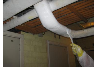
3. Application d'une peinture spéciale sur les bandes
