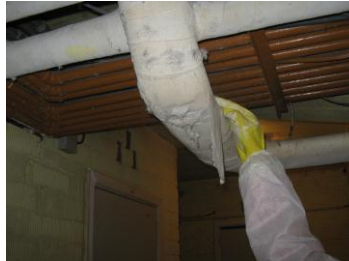
2. Application des bandes de plâtre sur le calorifuge
